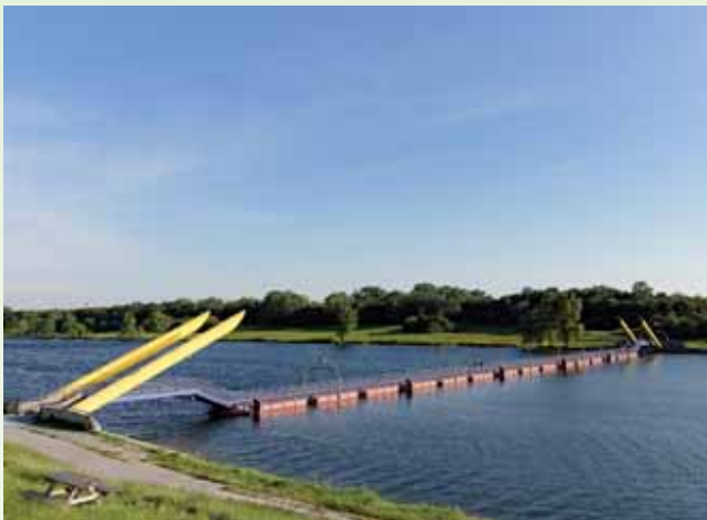
WALULISO-BRÜCKE ÜBER DIE NEUE DONAU
