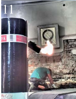
Flämmen der Feuchtigkeitsisolierung
