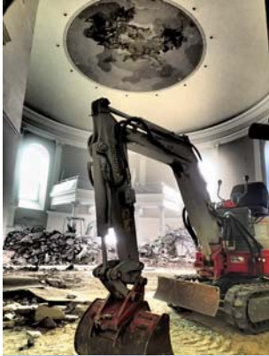
Erdaushub durch Kleinraupenbagger
